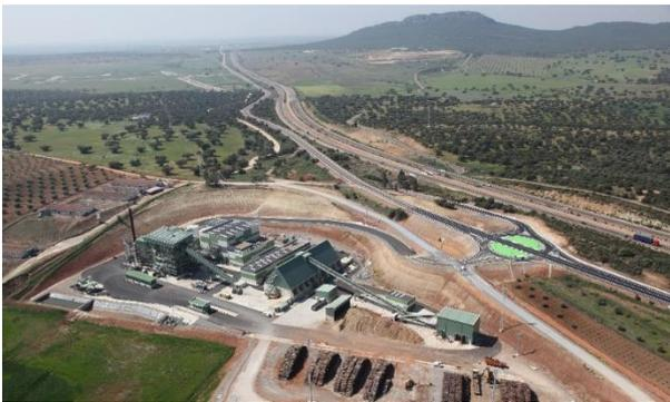
**Figura I:** Planta de biomasa perteneciente a **ENCE ENERGÍA EXTREMEÑA, S.L.** con una potencia térmica de 71,15 MW, diseñada para la generación de 20 MW de electricidad mediante el procesamiento de astillas de cultivo energético y restos forestales.
